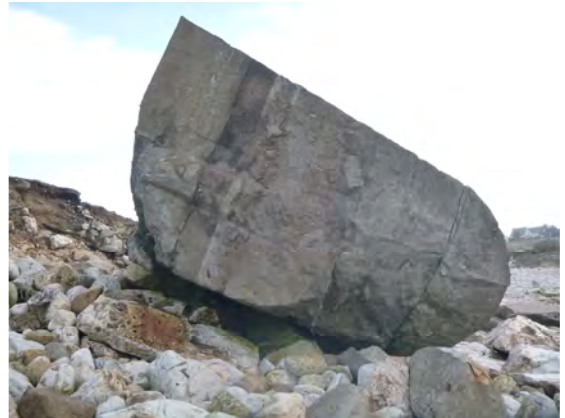
Bloc 2018-M1-B-11-0 renversé sur une grève et affecté de quelques épaufrures en rive
