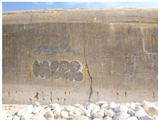
Bloc 2018-M2-B-14-0 affecté par de la fracturation verticale sans rejet à ouverture croissante vers la base (ouverture de 1.5cm à la base à quelques mm en tête) se développant sur toute la hauteur
