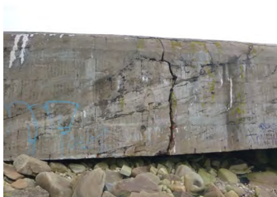
Fracture d'ouverture pluricentimétriques sans rejet horizontale ni décalage vertical significatif d'une absence de mouvement entre les blocs 2018-M4-B-1-0 et 2018-M4-B-2-0
