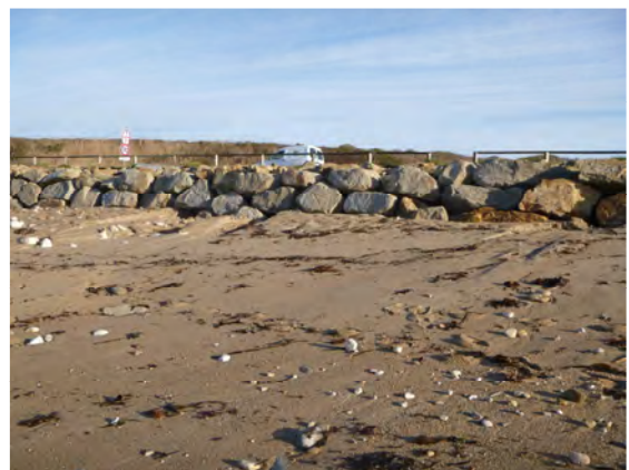
perré en enrochements formé de blocs de ~0.3 à 0.5 m 3 ,
