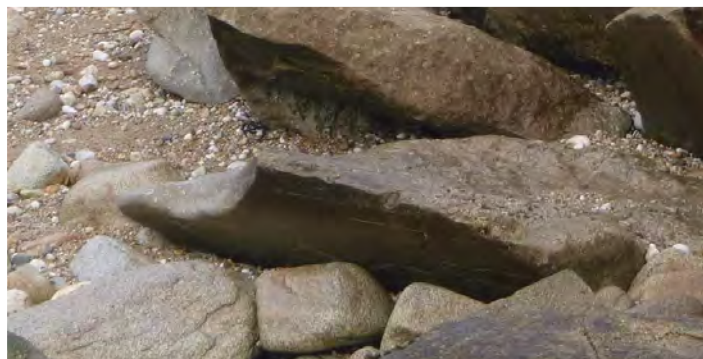
Bloc 2018-M3-B-4-8 d'un volume de \sim 0.7\text{m}^3 et affecté par une fissure médiane transverse
