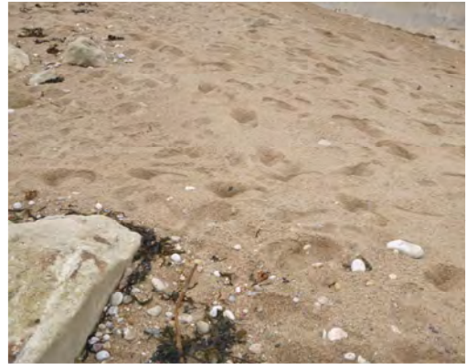
Sur la plage, à ~7m à l'arrière du bloc 2018-M2-B-13-0, armatures ressortant du sable sur 40cm
