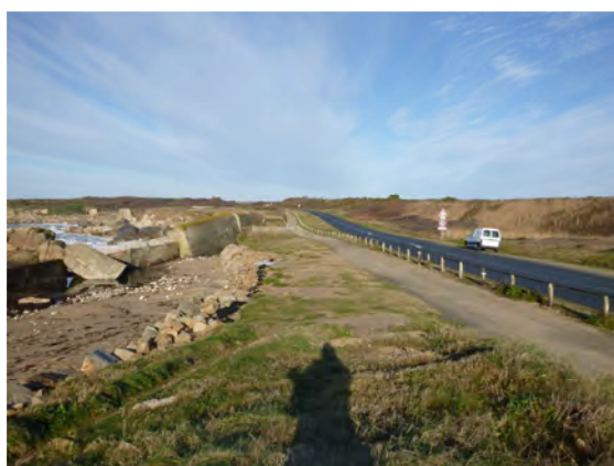
de ~P220 à ~P270, crête d'engrochements distante de ~5.5m du bord de piste cyclable et de ~9m du bord de chaussée
