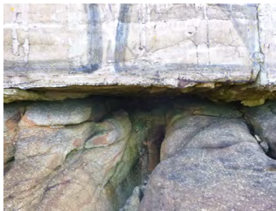
fondation directe du mur M4 sur assise rocheuse non travaillée
