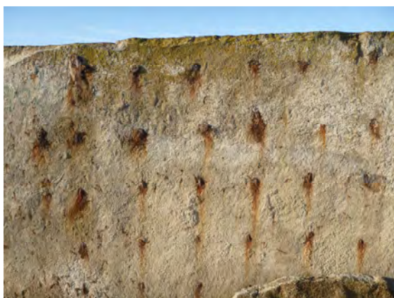
Semelle du bloc 3 du mur M2 avec treillis d'armatures métalliques avec maillage de 30 cm de côté
