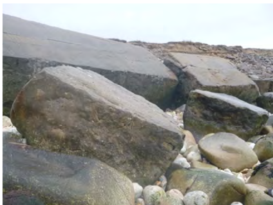
bloc 2018-M1-3-1 et bloc 2018-M1-B-3-2 en contrebas du bloc 2018-M1-B-3-0 et résultant de la fracturation de la partie supérieure de la structure primitive 42ans après son renversement
