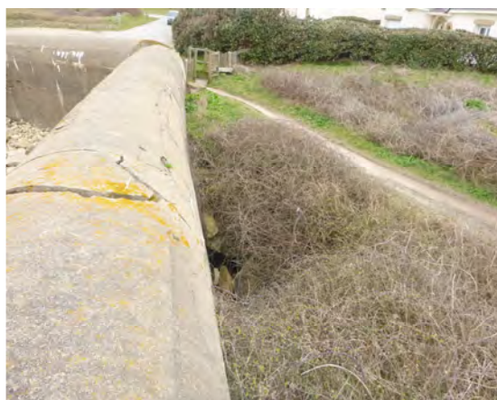
Dépression ancienne au droit du bloc 2018-M4-B-2-0 sur ~6 m de long et ~4m de profondeur
