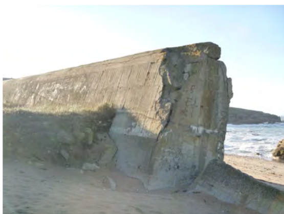
Mur en soutènement sur ~1.6m
