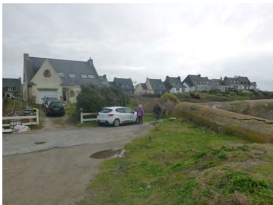
maison de la parcelle 183 à ~15m du coude du mur anti-char
