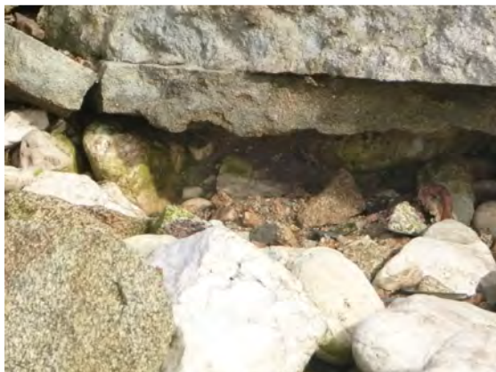
fondation du bloc 10 du mur M1 directe sur le paléosol formé d'un niveau argileux emballant des galets granitiques
