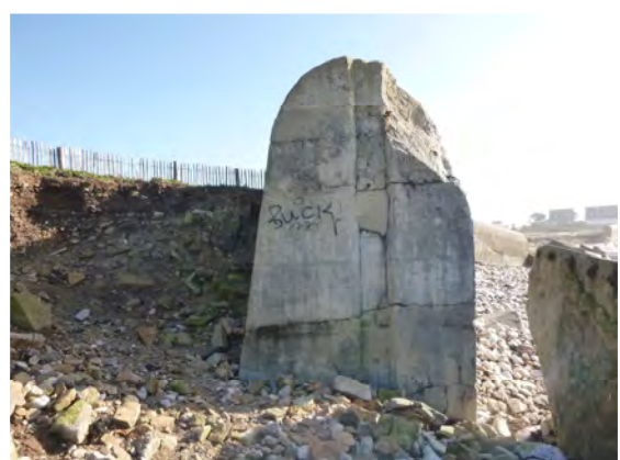
Mur en soutènement sur ~3m
