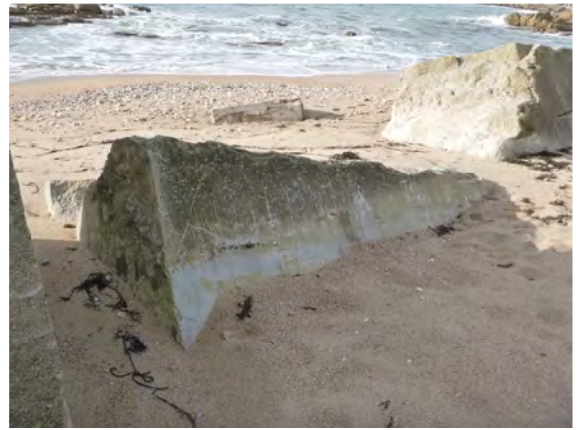
Recouvrement de sable en contrebas des profils ~P220 à ~P 340
