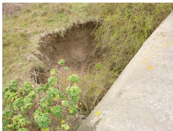
Vers P455, dépression au droit du bloc 2018-M4-B-4-0 de ~5m de long sur ~4 m de profondeur
