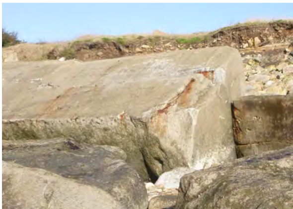
Bloc 2018-M1-B-4-0 avec armatures en saillie sur \sim 20\text{cm}
