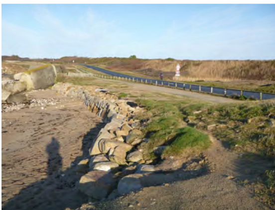
perré en enrochements (~P220 à ~P280)
